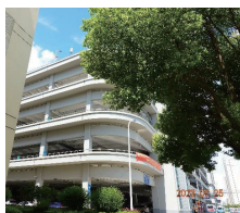
図6 EVバスの集中充電ビル
