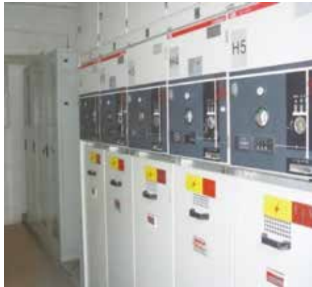
図12. 電力グリッド機器のバックアップ電源
