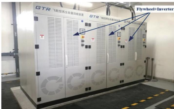
図2 北京地下鉄房山線広陽城変電所に設置したフライホイール回生電力吸収試験装置 (2019年)
