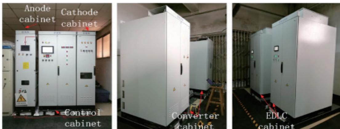
図1 北京地下鉄八通線梨園変電所に設置したEDLC回生電力吸収試験装置（2015年）
